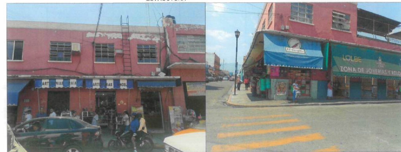
ESTADO DETERIORADO DE LA PINTURA DE LA ESTRUCTURA
