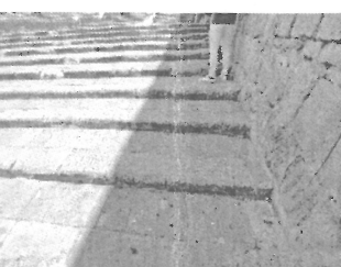
ESCALONES ELABORADOS CON PIEDRA CANTERA
