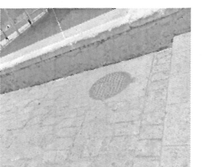
REGISTRO DE CFE UBICADO EN PISO DE CANTERA
