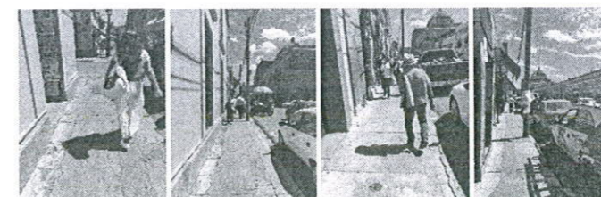
FOTOGRAFÍA 5-8. Estado actual de banqueta sobre la calle Valerio Trujano entre las calles de 20 de Noviembre y J.P. Garcia.
