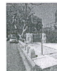
Fotografía 4: Protección de concreto de forma piramidal y cadena de protección con barandal metálico.
