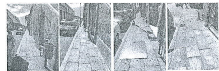
Foto 1. Foto 2. Foto 3. Foto 4. Piso de piedra cantera de 60x40x8 cm, asentado y junteado con mortero cal-arena proporción 1:3 sobre entortado de mezcla cal-arena de 2cm de espesor promedio
